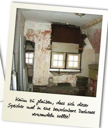
Während des Umbaus gab es viel zu tun!
